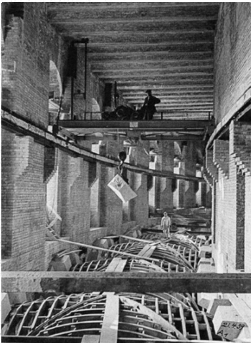
Der Bau des Arkadenganges. Erkennbar sind zwei Arbeiter und eine temporäre Schienenkonstruktion mit Kran. Die Schienen sind nicht mehr vorhanden. Das Foto ist datiert auf den 21. April 1939
